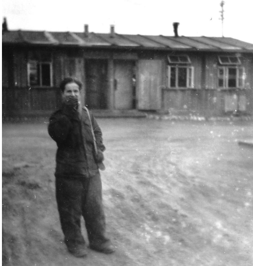
Georg Uhlig in Arbeitskluft vor einer Baracke
