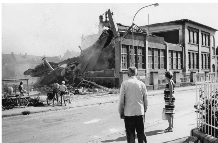
Kinder und Pas- santen verfolgen gebannt den Abriss der Fabrik- gebäude von Adrian & Busch.
