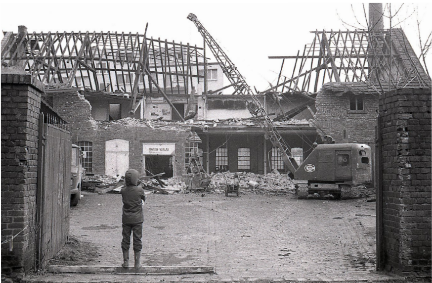
Der Bagger beschleunigt den Verfall, das Dach ist schon nicht mehr ganz dicht.
