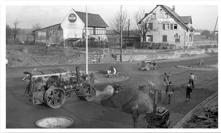
Das Gasthaus »Zu den Drei Hasen« mit der Scheune wird von den Verkehrsflächen des Kreisels bedrängt.
