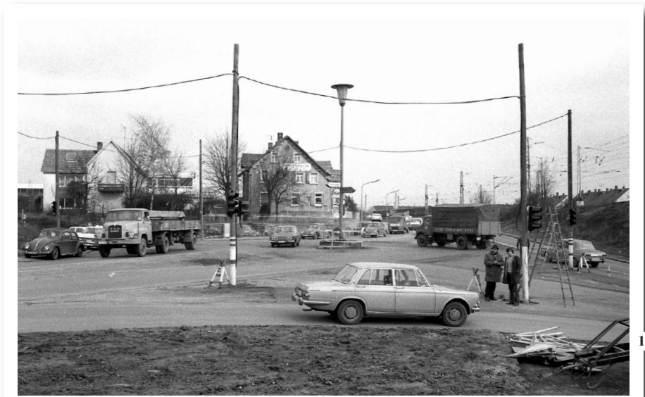
Den Kreisels hat das Gasthaus noch überlebt, der späteren Straßenüberführung fiel es endgültig zum Opfer.
