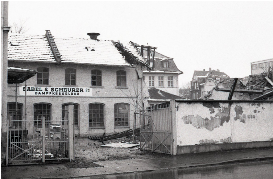
Die Gebäude Sabel & Scheurer von der Oberhöchstädter Straße aus, hier schon zum Teil abgerissen.
