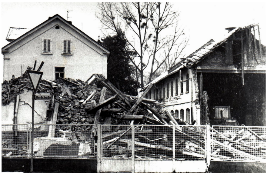
Die Ansicht von der Korfstraße aus im gleichen Abrisszustand. Das Eckhaus ist schon niedergelegt.
