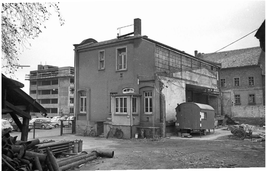
Die Rückansicht des gleichen Gebäudes kann den Niedergang nicht mehr verleugnen. Im Hintergrund der Robbau des neuen Rathauses.
