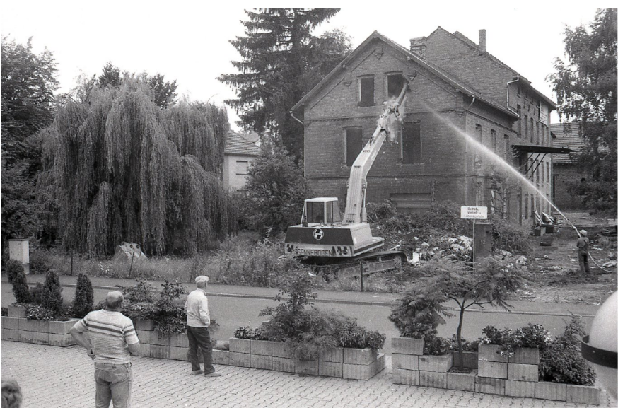
1981 greift der Abrißbagger zu, beobachtet von Zuschauern jenseits der Körnerstraße vor dem Rathaus.
