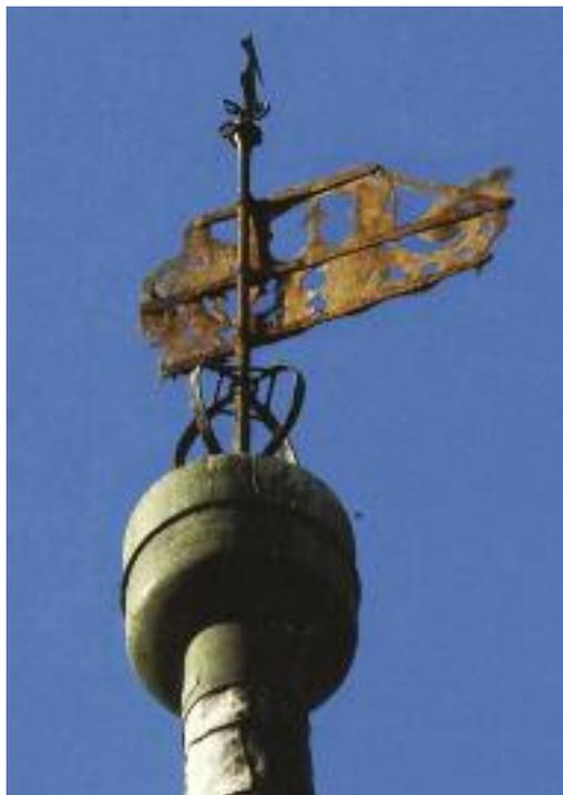
Abb. 12: Die Rückseite der Wetterfahne auf dem Alten Rathaus am Marktplatz zeigt schwere Witterungsschäden (Vorderseite siehe Abb. 1).
