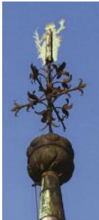
Abb. 22: Im Sonnenlicht zeigt die Rückseite, dass an Kugelknäuf und Blattwerk die Witterung auch hier ihre Spuren hinterlassen hat.
