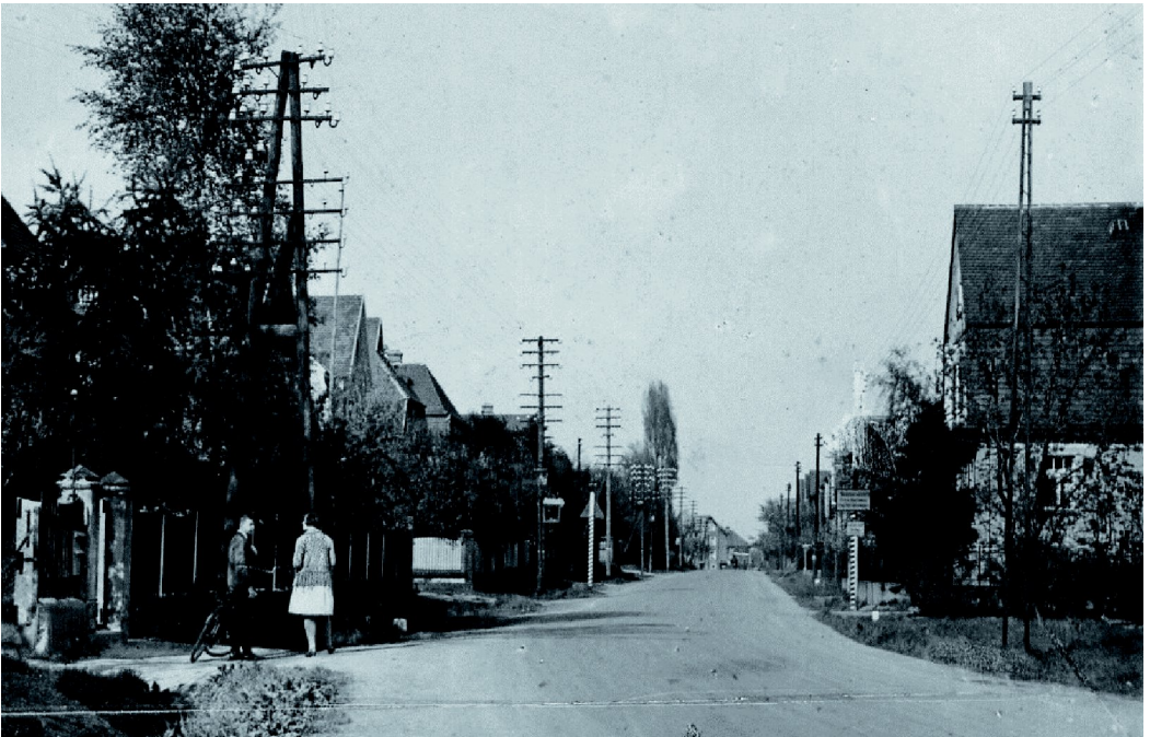
Abb. 10: Stromleitungen in der Homburger Landstraße in den 1920er Jahren. Links die Oberurseler Seite mit Holzmasten, rechts die Bommersheimer Seite, mit Ortseingangsschild und ersten Stablgittermasten.
