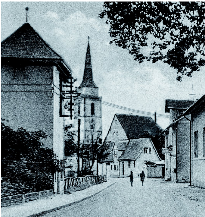
Abb. 9: Eine der frühen Umspannstationen in Oberursel, hier in der Obergasse. SAMMLUNG BERND OCHS, BEARBEITET VON GÜNTER HUJER
