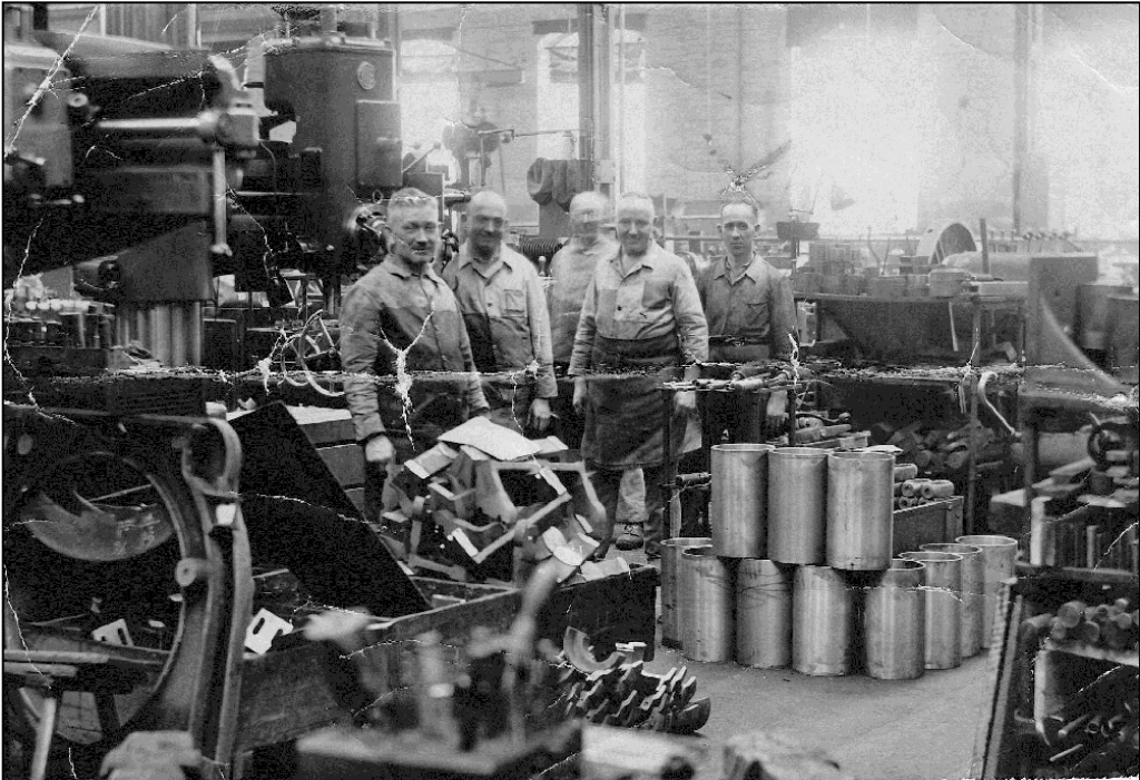
TURNER AG: Fertigung ca. 1950 Quelle: Fritz Simon
