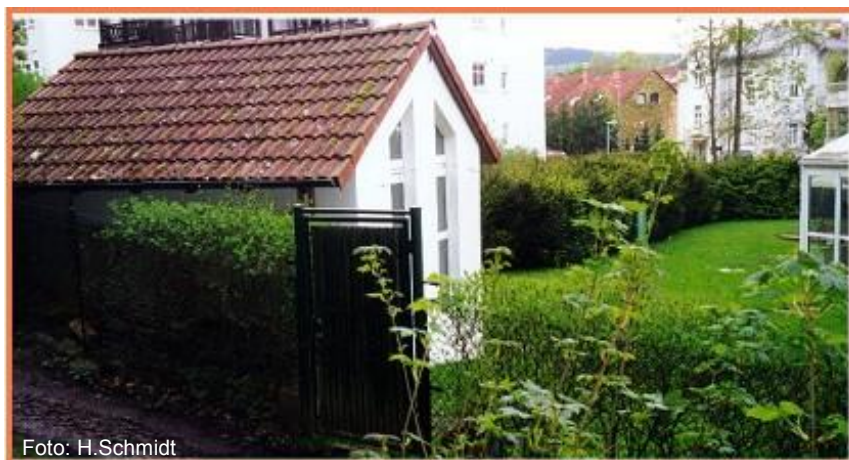
Kraftwerk Mägerlein mit 25 KW
