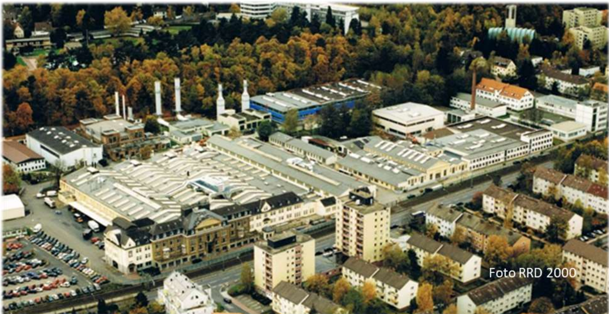
Die Motorenfabrik Oberursel – ein Standort von Rolls-Royce Deutschland
