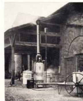
Dämpfkolonne Fig. 1 bei der Arbeit
