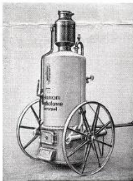
Abb. 4 Oekonom-Kessel mit Vorwärmer und Hubwagen
