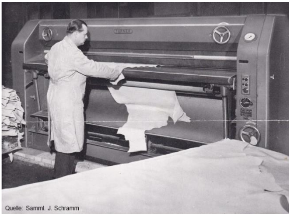
Quelle: Samml. J. Schramm Durchlauffalzmaschine Fa. Turner Bj. 1965
