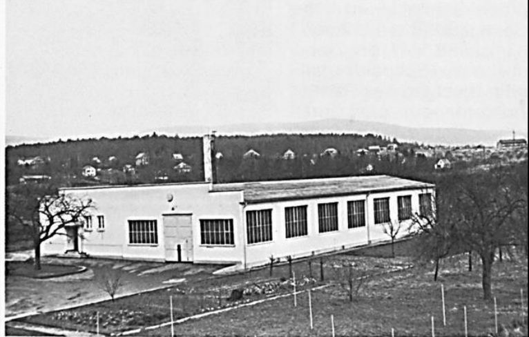
Die erste Halle, im Jahr 1953 erbaut
