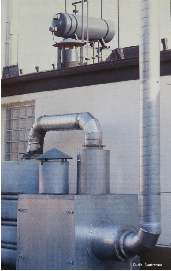
Biofilteranlage
