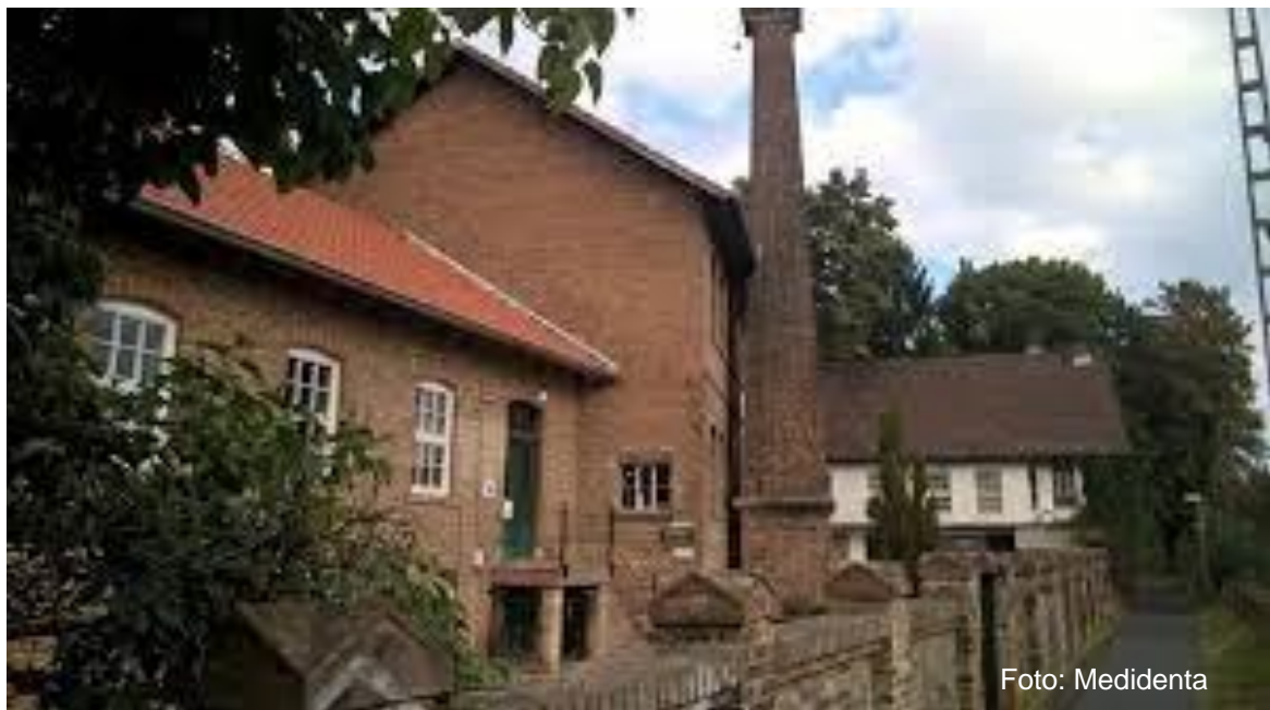
2016 Neubedachung des Bürogebäudes im alten Stil
