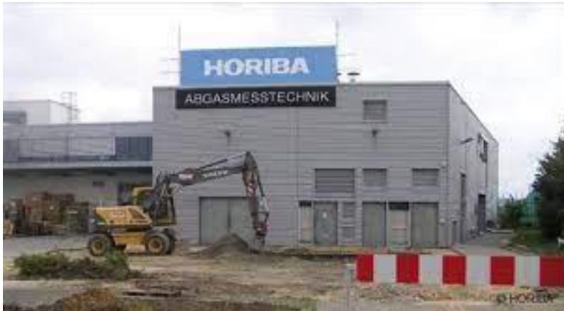
2014: Anbau des TestCenters Oberursel mit einer Soak Area (Konditionierungsraum) zur Erweiterung der Prüfkapazitäten
