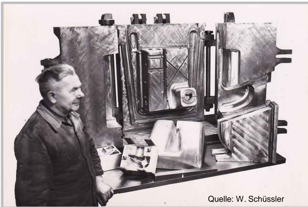
Stahl-Kokille f. Schneidmaschine Alu.-Abguß m. Croningkern
