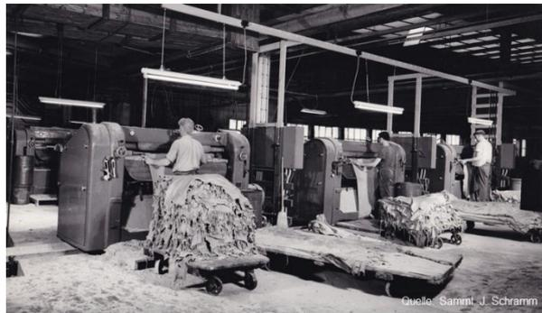
Elektro-hydraulische Durchlauf-Falzmaschinen Typ 540
