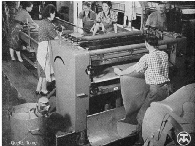
Appretier- und Färbemaschine mit Transportband. Arbeitsbreite 1600 mm
