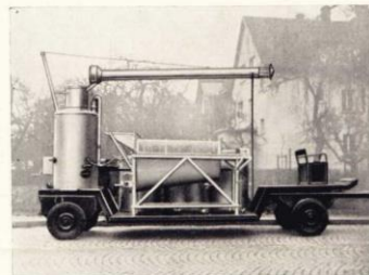
Dämpfkolonne Fig. 12 auf Tieflader luftbereit
