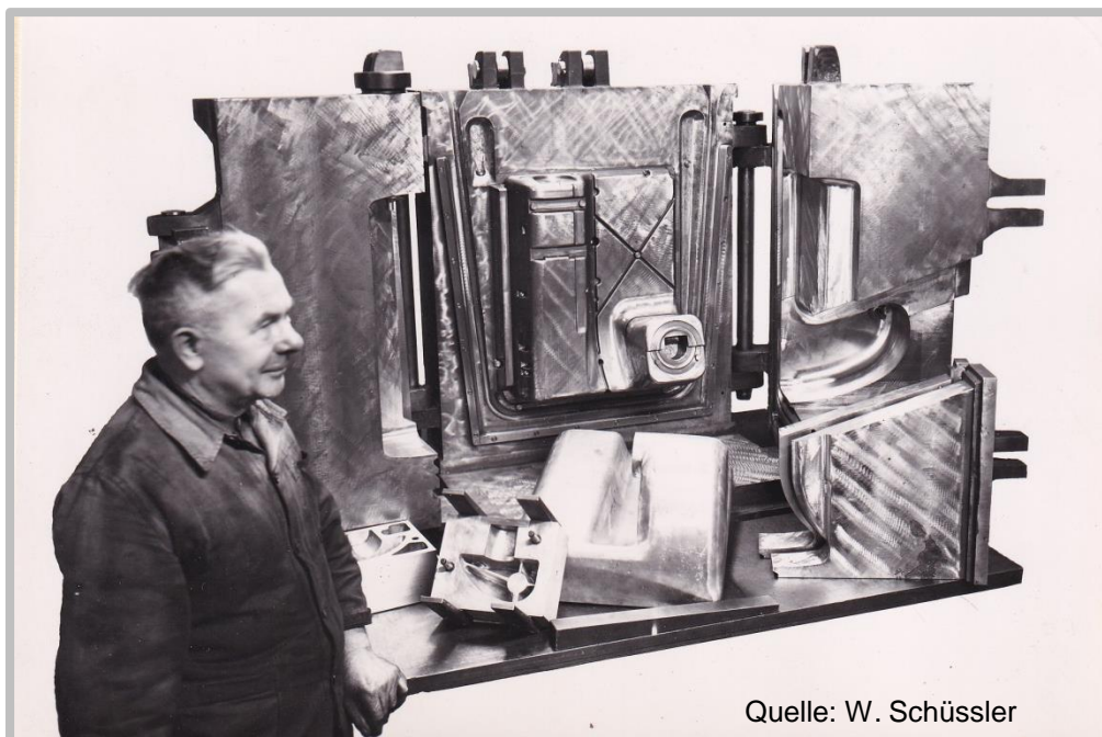
Stahl-Kokille f. Schneidmaschine Alu.-Abguß m. Croningkern
