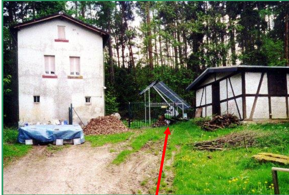
Automatischer Rechen (Reinigungsanlage) mit Förderband
