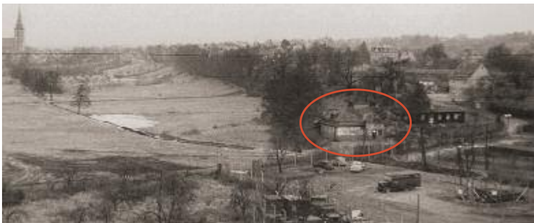
Die 1918, also 16 Jahre vor dem Aufbau der städtischen Kanalisation, als erste in Oberursel errichtete und bis 1957 betriebene Kläranlage der Motorenfabrik Oberursel.
