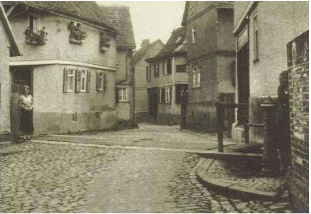
1934 – Der Brunnen in der Obergasse Ecke Kirchgasse (heute St. Ursula-Gasse). Vor dem Werkgraben mit der 1956 beseitigten »Donnerbrücke« der gusseiserne Laufbrunnen mit Ablaufmulde und Zulauf zur »Bach«.
