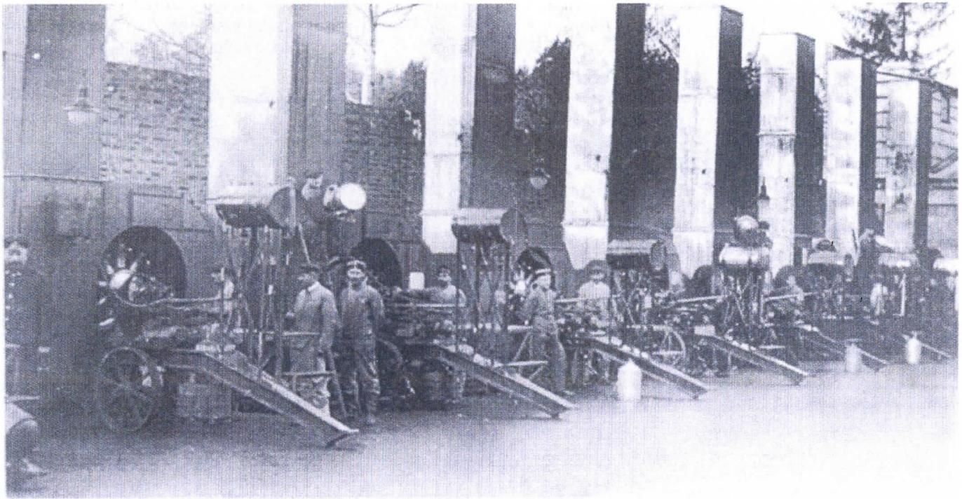
*Motorenfabrik Oberursel – engine acceptance testing*
