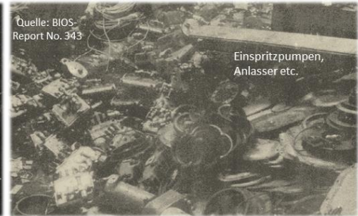
Weiterverwertung von zunächst von den Amerikanern achtlos zusammengeworfenen Bauteilen von A/F4M517-Motoren
