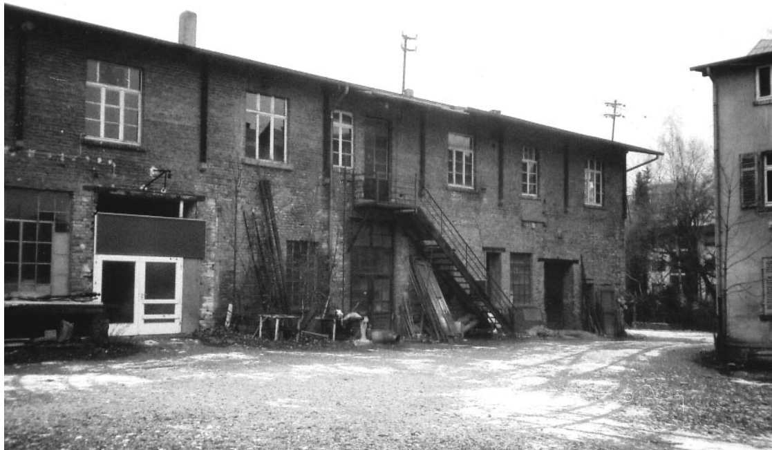
Fabrikgebäude des ehemaligen Rompel'schen Kupferhammers, rechts Wohnhaus
