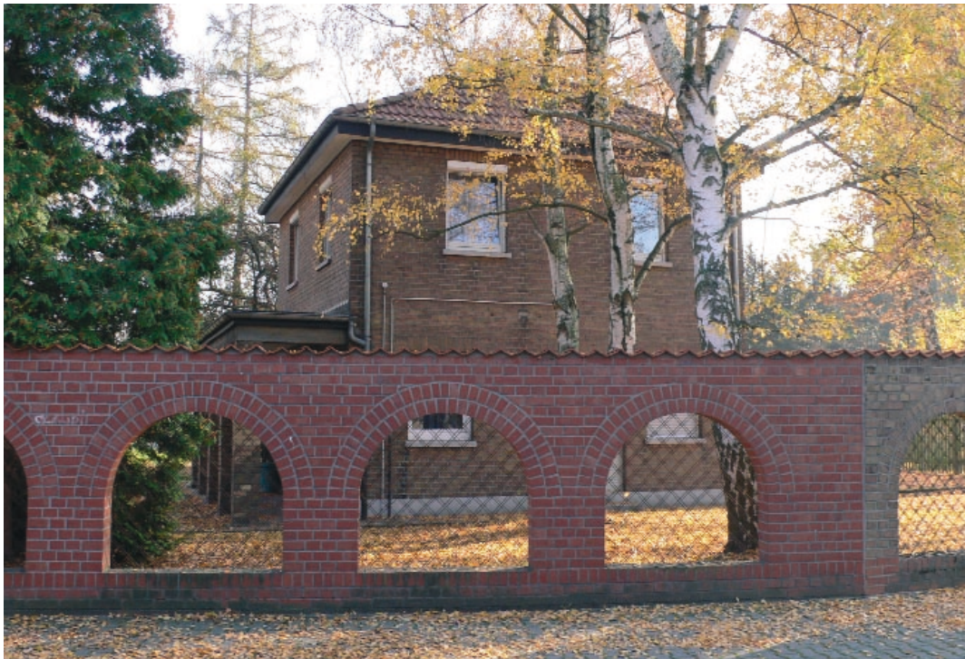
Ehemaliges Pförtnerhaus mit Bogenmauer der Firma Schütz von der Kurmainzer Straße aus. (Siehe Plan Nr. 1)
