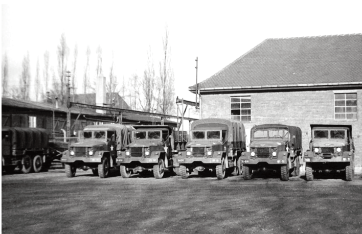
Line-Up von Transportfahrzeugen des US-Militärs in der Motorenfabrik
