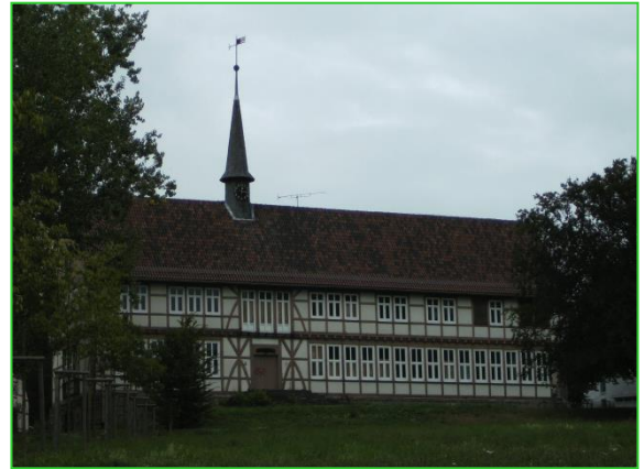
Herbst 2013 vor dem Umbau
