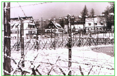
Das Gelände wird eingezäunt
