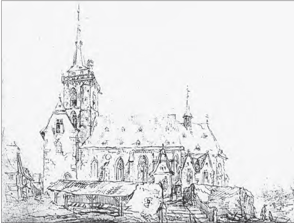
In der Michaelskapelle, rechts vor dem Kirchturm im Obergeschoss, war die Lateinschule untergebracht. Die Zeichnung von Franz Schütz zeigt die Kapelle, die 1645 ausbrannte, im Jahre 1776
