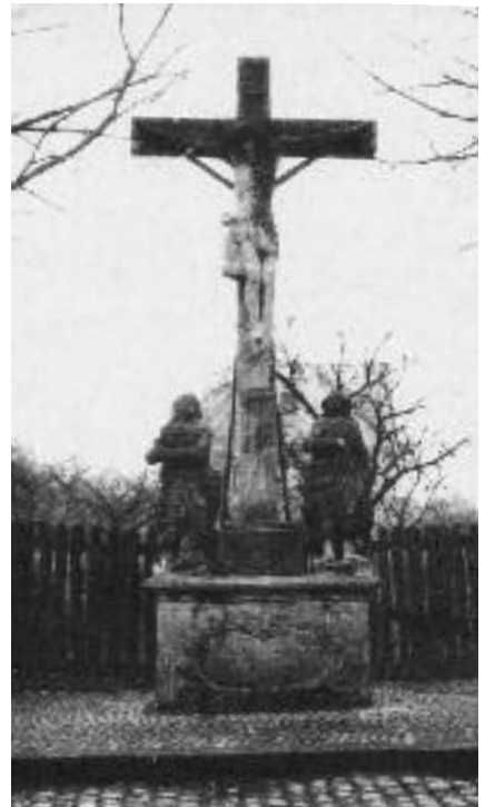
Das Kreuz vor 1955 an seinem Standort Eppsteiner Straße.
