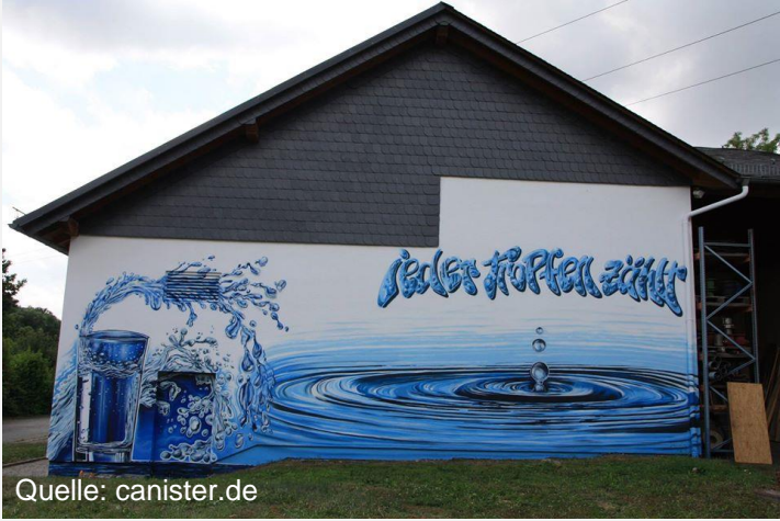
Wasserwerk Eschbach an der B 275
