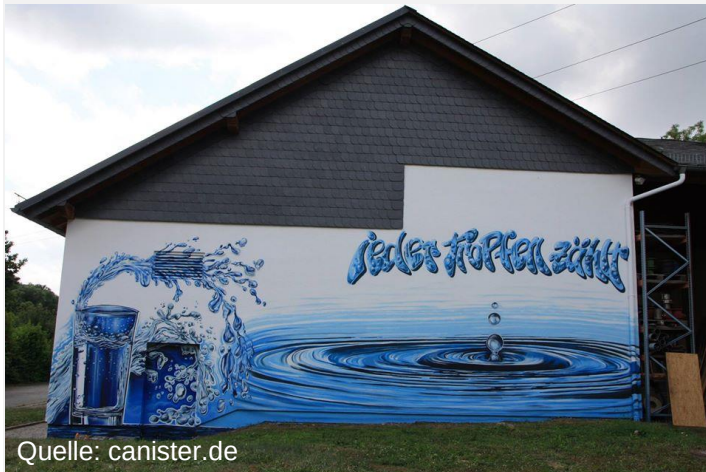
Wasserwerk Eschbach an der B 275
