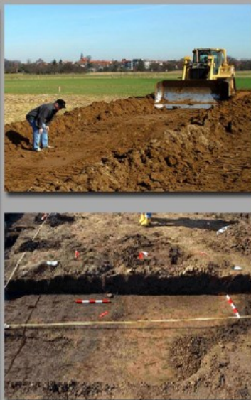
... auf einer Straßenbaustelle bei Ober-Erlenbach oder auf einem Acker in Oberursel-Bommersheim
