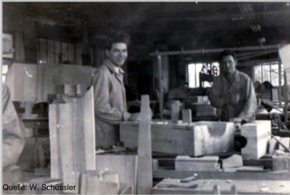
Großmodellbau Spiralgehäuse
