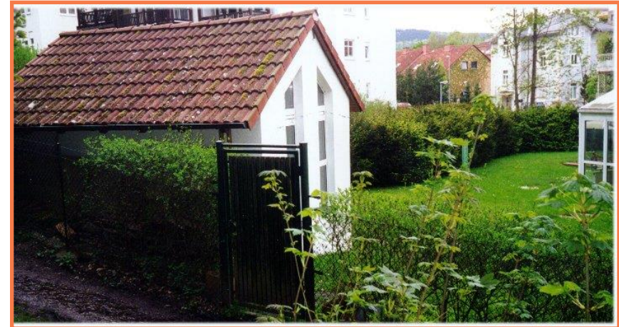
Kraftwerk Mägerlein mit 25 KW
