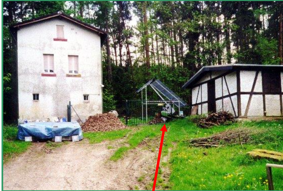
Automatischer Rechen (Reinigungsanlage) mit Förderband
