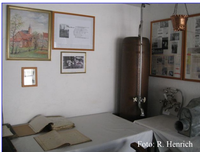
Erster Badeofen holzbeheizt
