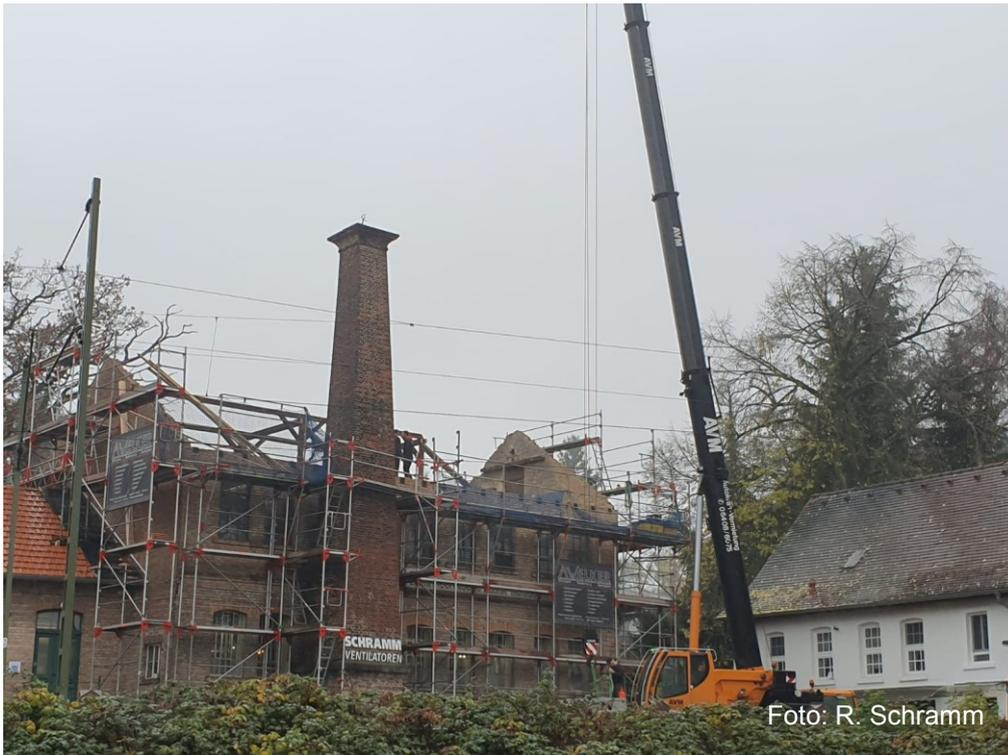
Foto R. Schramm - Der Dachstuhl und das Dach des Hauptgebäudes werden erneuert.
