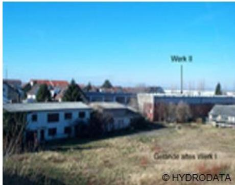
Erkundung und Sanierung einer Boden- und Grundwasserkontamination durch MKW und LCKW sowie Planung und Überwachung des Rückbaus bestehender Gebäude auf dem Gelände eines ehemaligen metallverarbeitenden Betriebes. Die Bodensanierung erfolgte mittels Bohraustauschverfahren und mikrobiologischer on-site-Sanierung der MKW-belasteten Bodenbereiche. Die noch laufende Grundwassersanierung erfolgt über Pump&Treat (Abreinigung mittels UV-Oxidation und nachgeschalteter Strippanlage).
