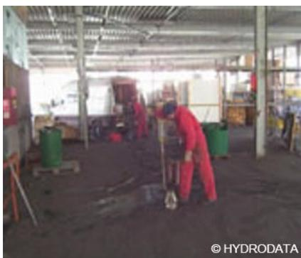
Erkundung und Sanierung einer Boden- und Grundwasserverunreinigung durch LCKW und Schwermetalle. Ausführungsplanung der Bodensanierung. Die Grundwassersanierung erfolgt mittels Air-sparging und Pump&Treat (Abreinigung über Strippanlage und nachgeschalteter Absorption für die Schwermetalle).
