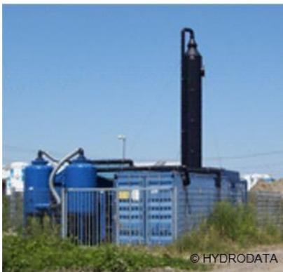
Erkundung und Sanierung einer Boden- und Grundwasserverunreinigung durch LCKW. Die Grundwassersanierung erfolgt mittels Pump & Treat über drei Reinigungsanlagen (Abreinigung jeweils über Strippanlage und Wasseraktivkohle mit nachgeschalteter Wiederversickerung). Zur Sanierungsoptimierung wurde ein dreidimensionales numerisches Grundwasser- und Schadstofftransportmodell erstellt.
